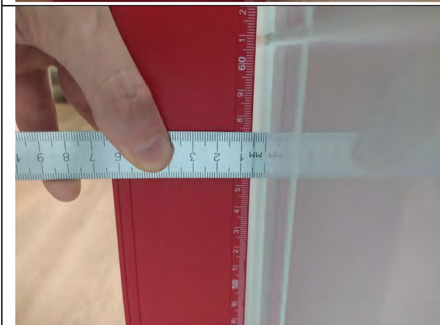
Фото №11. Измерения уровня стен в санузле.
