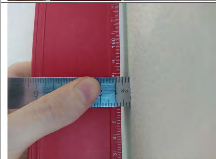
Фото №8. Измерения уровня стен в спальне.
