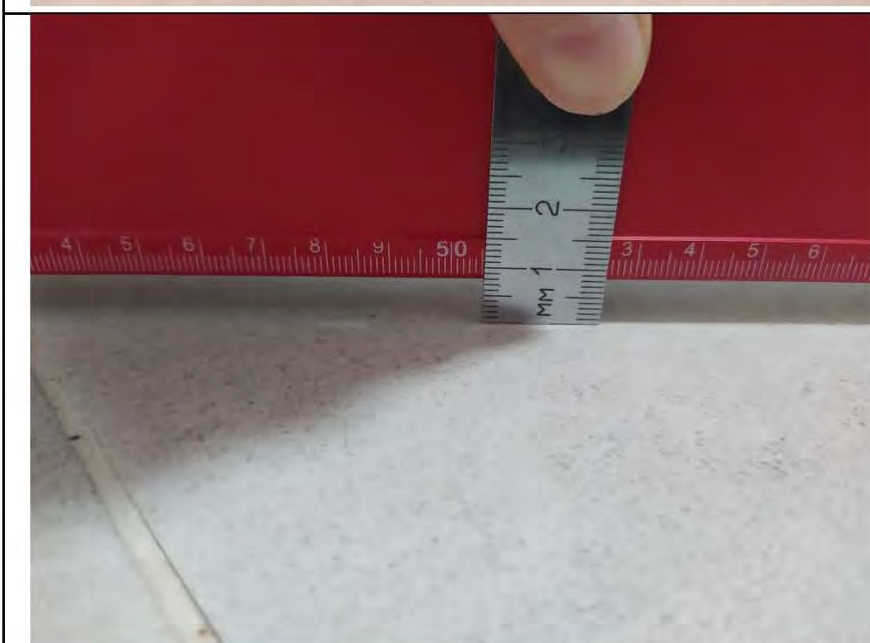
Фото №18. Измерения уровня напольного покрытия в ванной комнате.
