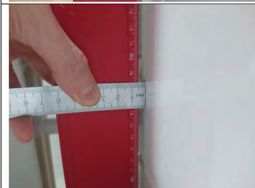
Фото №12. Измерения уровня стен в ванной комнате.
