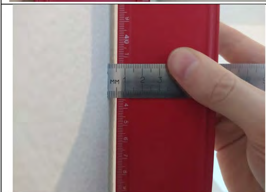
Фото №9. Измерения уровня стен в кухне.
